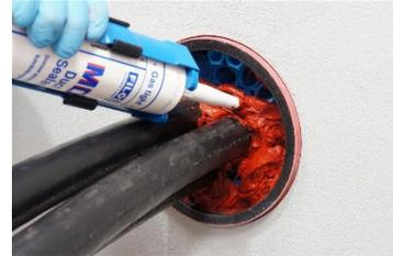
※シリコンコンパウンドは湿気により硬化しますが、作業では付属専用スポンジで表面を濡らします
