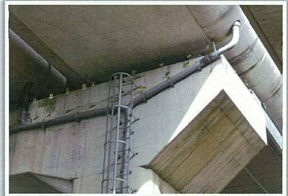
橋脚雨水管及び支承部
