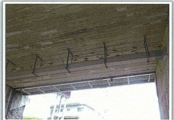
橋梁下部ボックス
