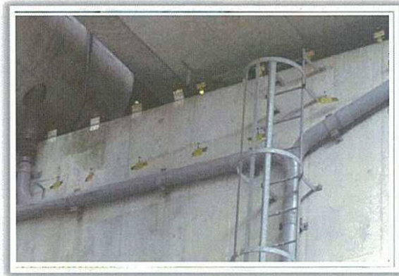
支障部分及び配水管上部
