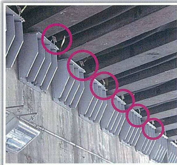
橋脚支持金具部分
