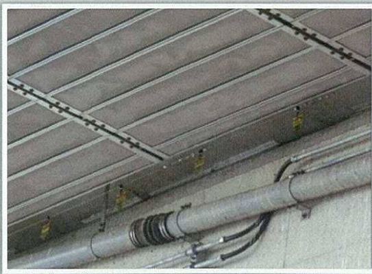
橋脚雨水管部
