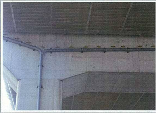
橋脚雨水管部
