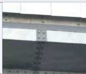
施工部分の拡大： 金属カバーとモルタルの間の 雨水の浸入を防止。
