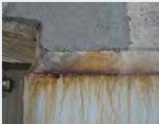
補修施工前の状態： 鋼板上端部で雨水・融雪剤・モルタルから発生した イオン性成分により腐食が進行中。
