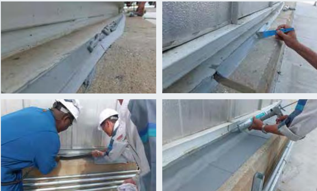
施工中 (シリコーンスポンジのバックアップとシーラントマスター300を用いてスロープ付け: 施工断面略図参照)
